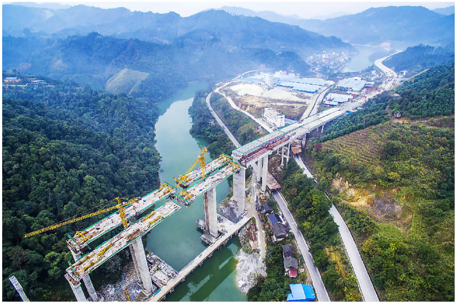
作为广西壮族自治区重点建设项目——桂林至三江高速公路自2013年开工以来,目前已完成主体工程的75%,预计在2017年国庆节前全线通车。目前,该高速公路(龙胜段)瓢里镇境内上塘河大桥已进入连续钢箱梁施工阶段,预计12月底完成大桥合龙。据了解,该大桥全长536米,总投资7948万元。图为11月17日航摄的上塘河大桥。
