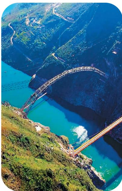
11月15日，由中国中铁大桥局采用“二次竖转”工法施工的大桥——新建大理至瑞丽铁路澜沧江特大桥钢管拱实现高精度合龙。澜沧江特大桥横跨澜沧江两岸，全长528.1米，主跨342米。图为澜沧江特大桥钢管拱。 新华社发
