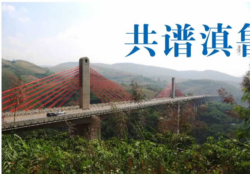
图为云南首座矮塔斜拉桥锁蒙高速南盘江特大桥。 谢明摄
