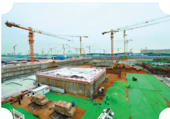
建设中的北京城市副中心行政办公区工程。孙 戊摄
