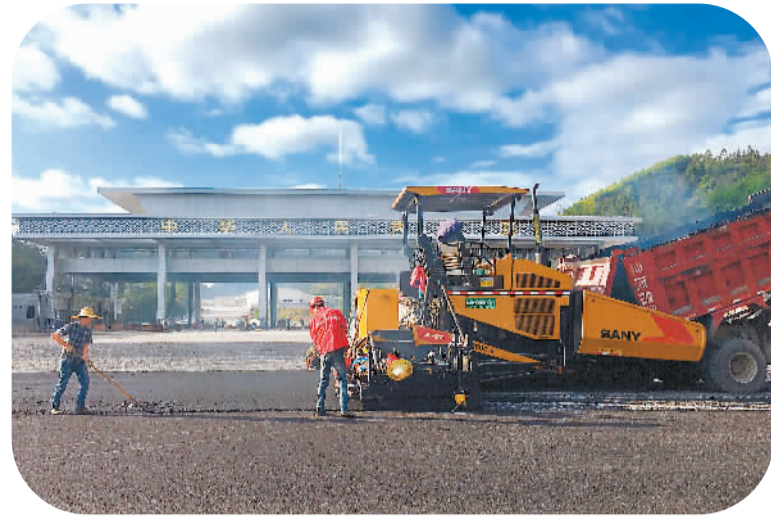
中国龙邦—越南茶岭跨境经济合作区是中越广西边境地区西路重要的陆路通道和主要的边境口岸经济合作区，是广西百色建设开放门户城市的重要载体之一。目前，该合作区项目建设如火如荼。图为工程建设者在龙邦口岸前加班加点铺设沥青道路。
