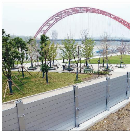
由武汉市城市防洪勘测设计院牵头自主研发的拼装式防洪墙，日前在湖北汉口江滩流通巷段投入使用。
