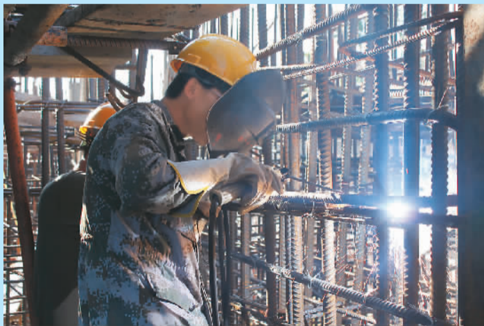
战士们在某发射场建设中进行焊接
