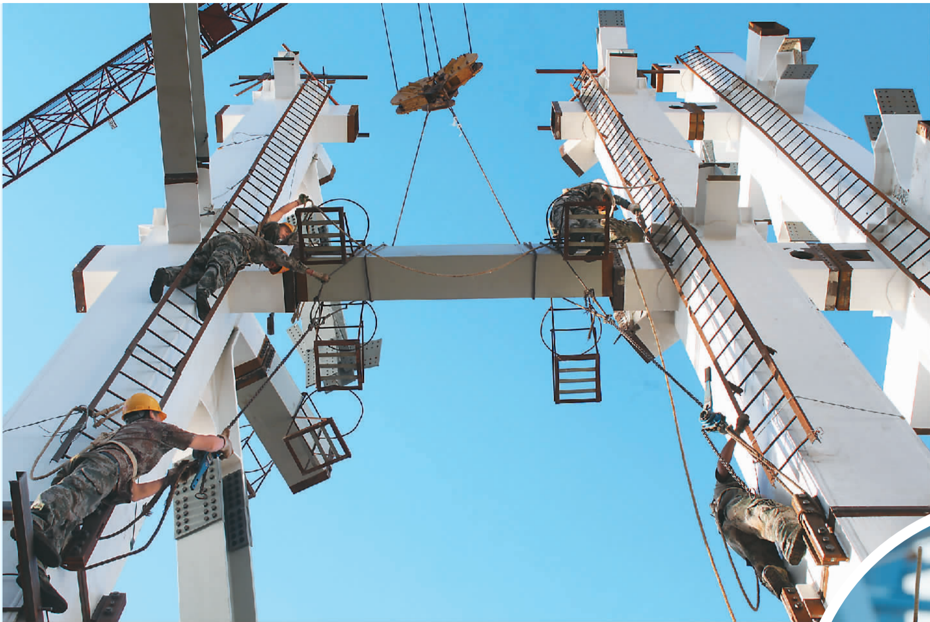
“蜘蛛侠”发射塔架高空安装
