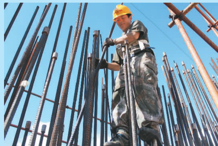
踩着高跷进行施工
