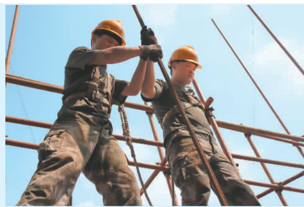
在高空支钢筋
