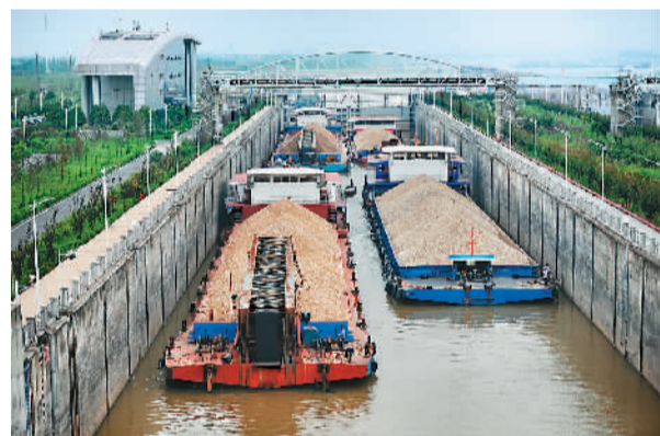
湖南加速水运建设融入长江经济带。图为满载运行中的湘江长沙综合枢纽船闸。新华社记者 龙弘涛摄
