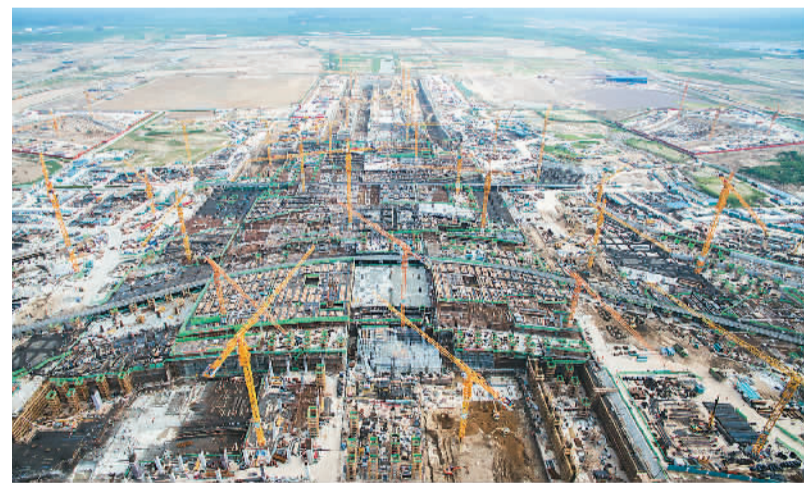
▲北京新机场建设工地
