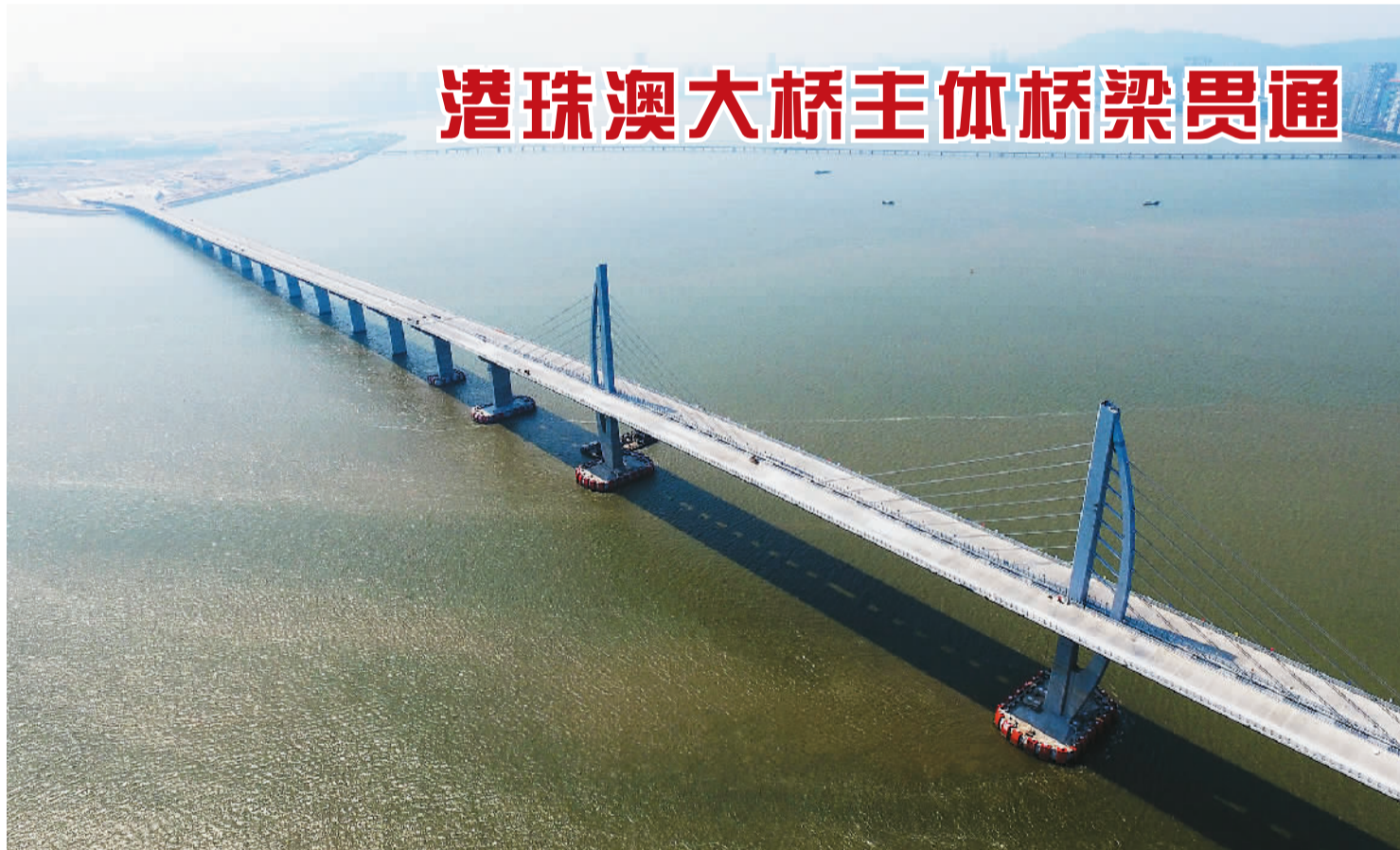
九月二十七日,港珠澳大桥主体桥梁正式贯通。港珠澳大桥是连接香港、珠海、澳门的超大型跨海通道,全长五十五公里。图为港珠澳大桥九洲航道桥的风帆造型桥塔。 新华社记者 梁旭摄 (详细报道见第三版)
