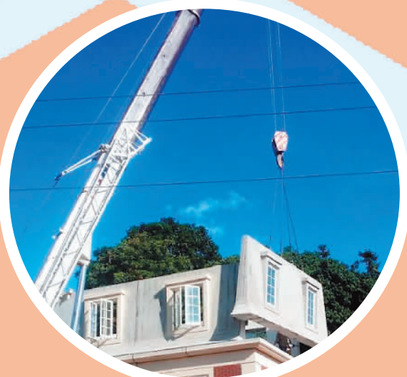
吊车正在吊装预制板。 (资料图片)
