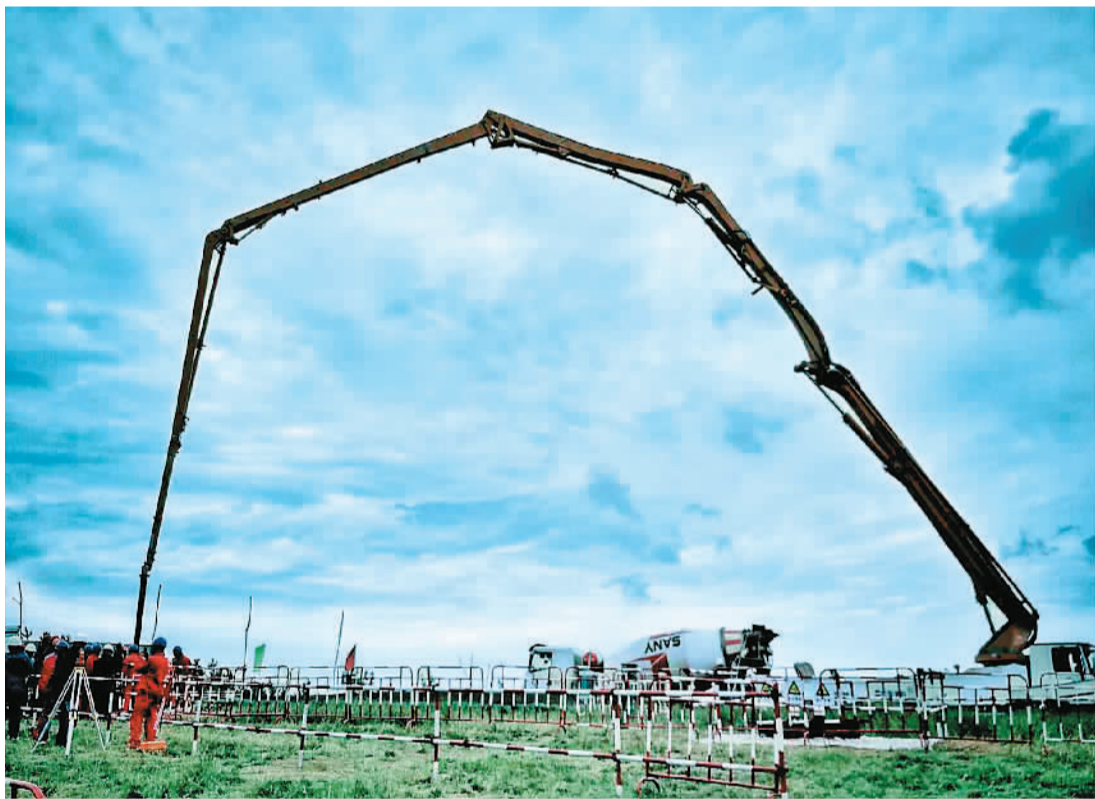
昌吉—古泉±1100千伏特高压直流输电线路工程陕西段首基础浇筑在陕西咸阳淳化县十里塬镇顺利完成，标志着陕西段正式开工建设。
