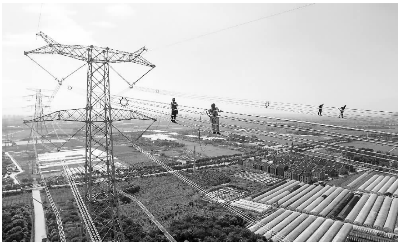
近日，冒着36摄氏度高温，国网上海电力公司检修公司验收人员对“皖电东送”特高压北线进行验收...
