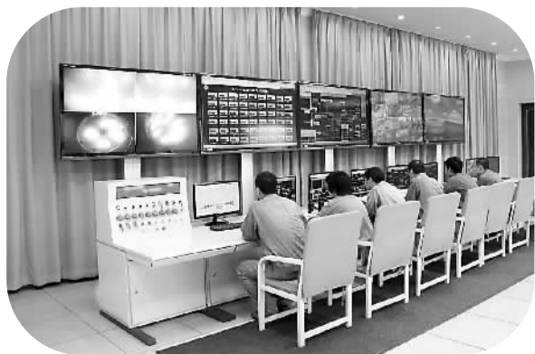
图为锦州石化苯乙烯车间中央控制室。
