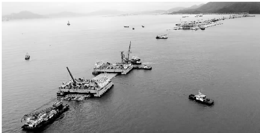
7月13日，港珠澳大桥管理局发布消息称，7月12日18时，港珠澳大桥海底隧道建设再下一城，直线段隧道的最后一段管节——E28沉管安装成功，隧道总长达4860米，对接误差仅3毫米。港珠澳大桥海底隧道由33节沉管对接而成。图为E28沉管安装现场（7月12日摄）。新华社记者 周强摄
