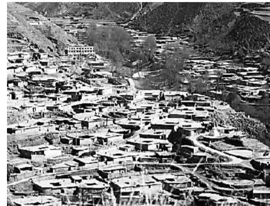
塔加村“布达拉式”的建筑风格
