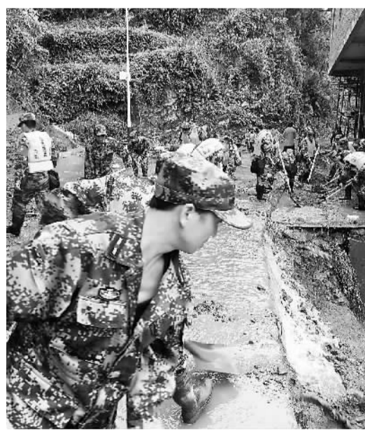
图为彝良县民武部组织民兵紧急抢通救援道路
