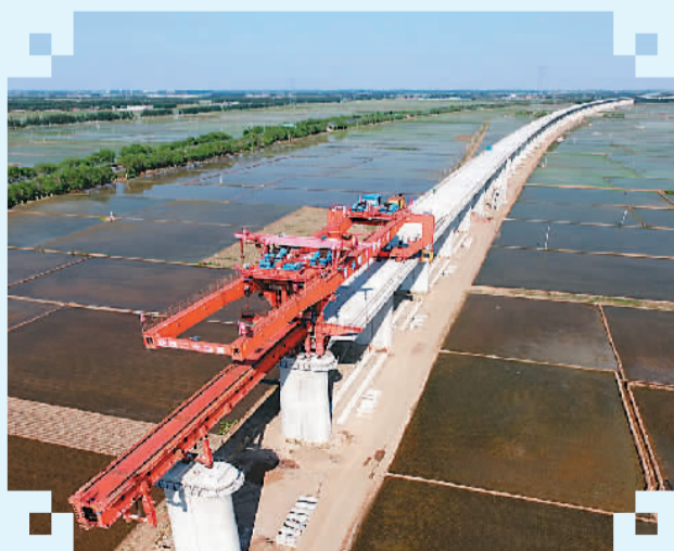
图为巨型架桥机正在架设桥梁。
