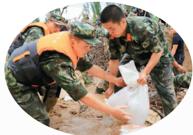
新疆博尔塔拉蒙古自治州博乐市小营盘镇一处堤坝因暴雨决堤,边防官兵迅速前往封堵。张 佳 摄(人民视觉)
