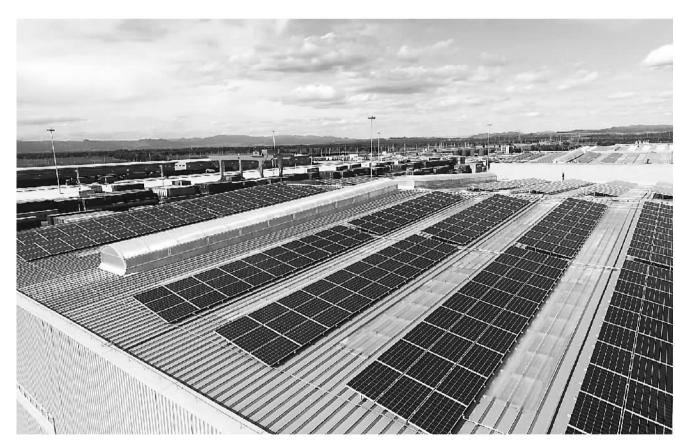
6月30日,全国铁 路系统首个光伏发电示 范项目"呼铁光伏"在 内蒙古呼和浩特沙良物 流园成功并网发电。该 项目是呼和浩特铁路局 利用铁路建筑屋顶及附 属场地,铺设光伏板发 电,所发电量主要用于 铁路运输和生产。项目 建成后, 总装机容量约 16.5兆瓦,年发电能力 约为2475万千瓦时, 年发电利润约为673万
