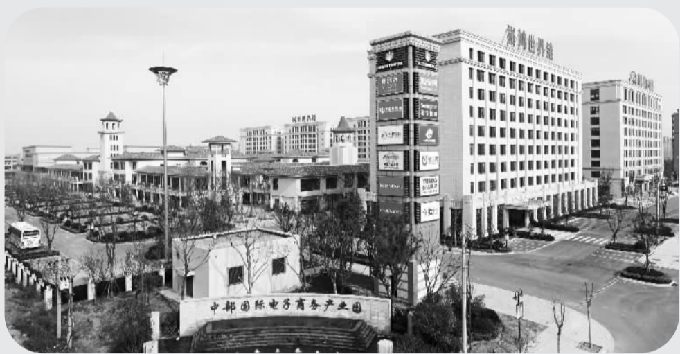
中部国际电子商务产业园
