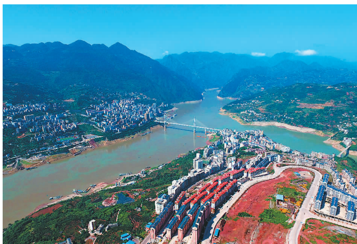
三峡库区最大的滑坡避险搬迁工程——湖北省巴东县黄土坡滑坡整体避险搬迁工程, 经过近8年的建设, 目前进入尾声。用于安置群众的神农溪小区, 目前累计完成投资10亿元, 移民安置房安置2206户已竣工, 6月底完成搬迁入住。图为小区一角。梁斌摄 (人民视觉)
