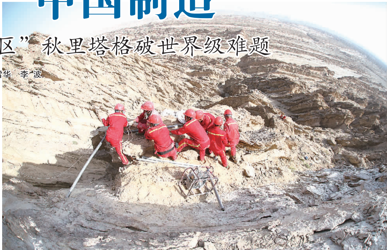
悬崖上的钻井施工。苏华拍摄
