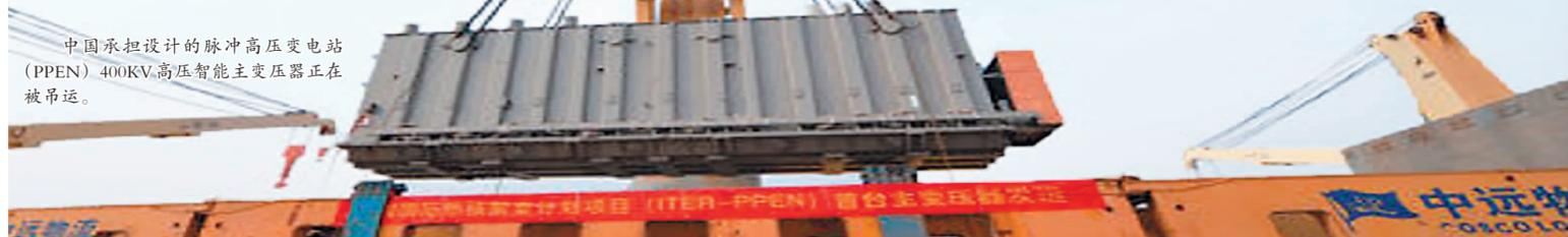
中国承担设计的脉冲高压变电站（PPEN）400KV高压智能主变压器正在被吊运。
