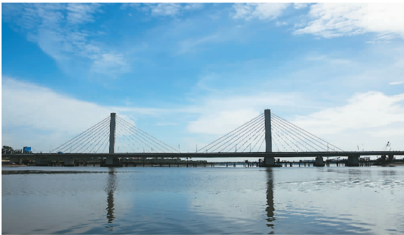
图为基甘博尼大桥全景。
