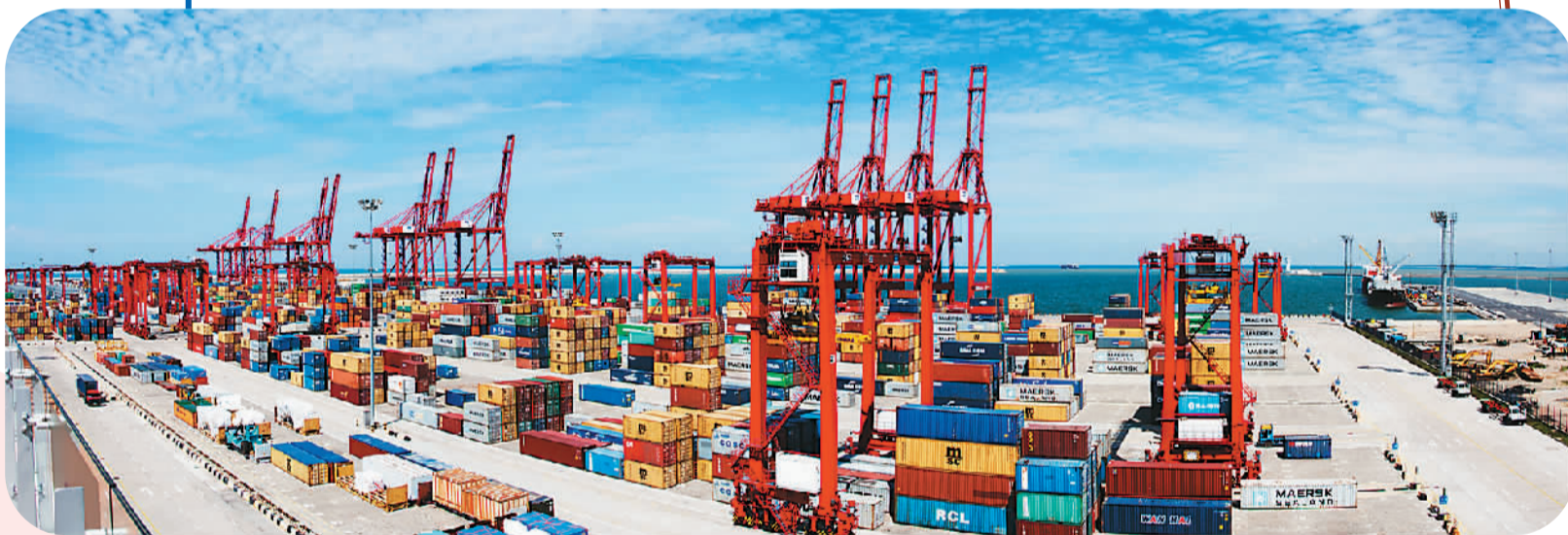
图为中国和斯里兰卡共建“21世纪海上丝绸之路”务实对接标杆性项目科伦坡南港集装箱码头。刘鸿儒摄(新华社发)
