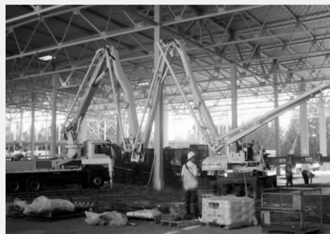
中联重科混凝土泵车在德国
