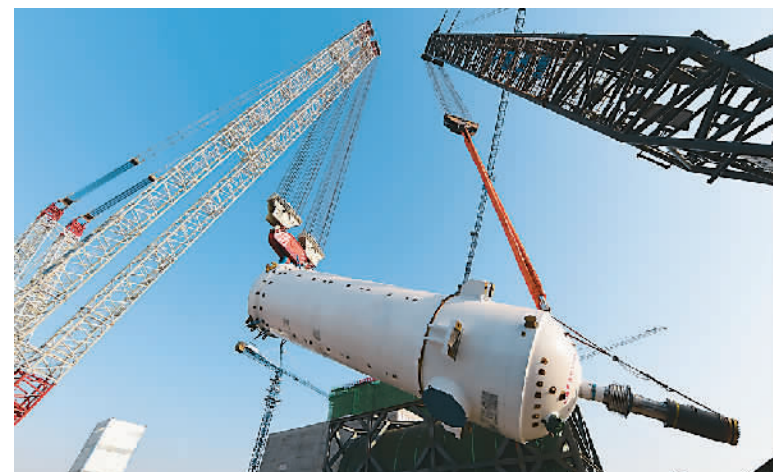
3月20日,全球首座四代核反应堆压力容器在位于山东荣成的华能石岛湾核电厂吊装成功,标志着我国在高温气冷堆示范工程建设和核电装备制造两方面均取得重大突破。本次吊装的压力容器高约25米,重约610吨,是目前世界上制造难度最大、尺寸最大、重量最重的核电站压力容器。图为反应堆压力容器在吊装中。新华社记者 郭绪雷摄
