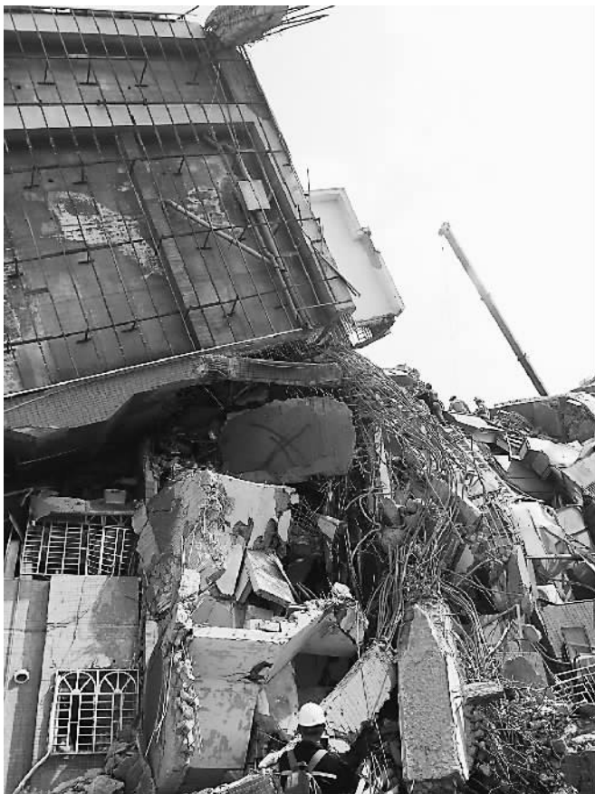
倒塌的维冠金龙大楼。
