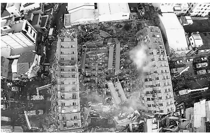
图为2月6日航拍的台南永康区维冠金龙大楼倒塌现场。
