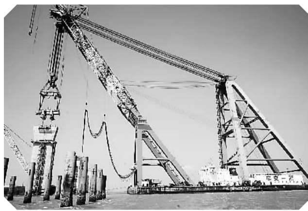
港珠澳大桥施工现场。新华社记者 魏蒙摄
