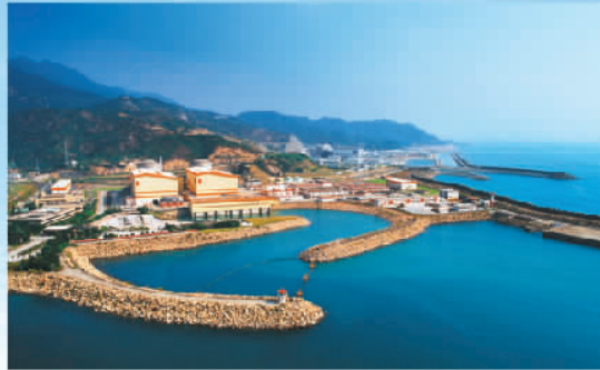
邮储银行融资支持中广核集团大亚湾核电站
