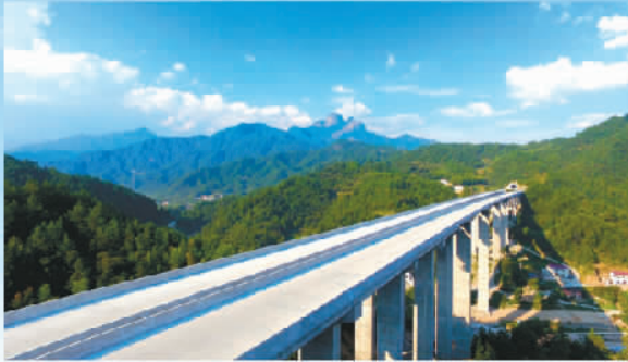
邮储银行资金支持的岳武路改造项目
