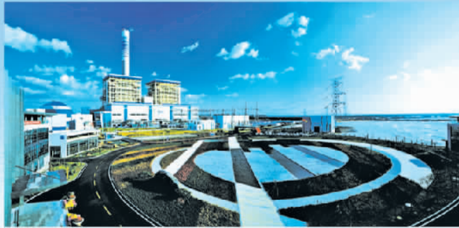
邮储银行合作支持的华电莱州发电项目
