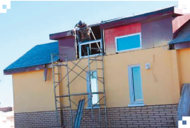
图为正在安装的“智能”房屋
