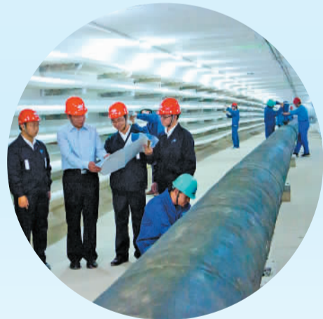
横琴地下市政综合管廊
