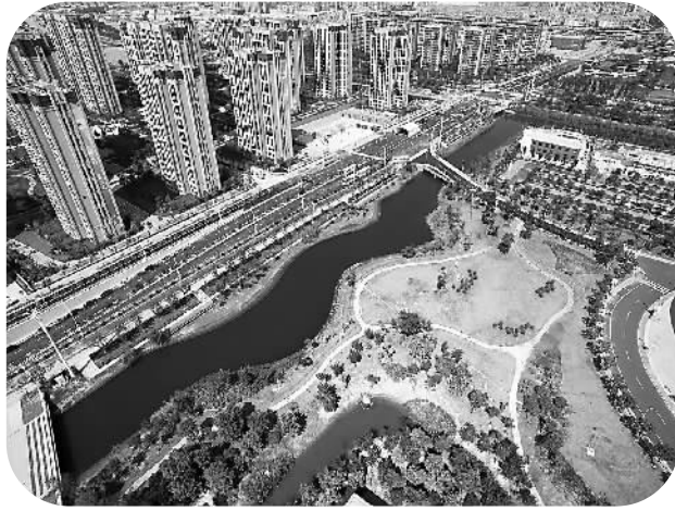
福州海绵城市建设项目——福州海峡奥体中心雨水花园已建成并发挥功能。该项目为下沉式绿地雨水花园，能使雨水充分渗透蓄积。新华社记者 林善传摄
