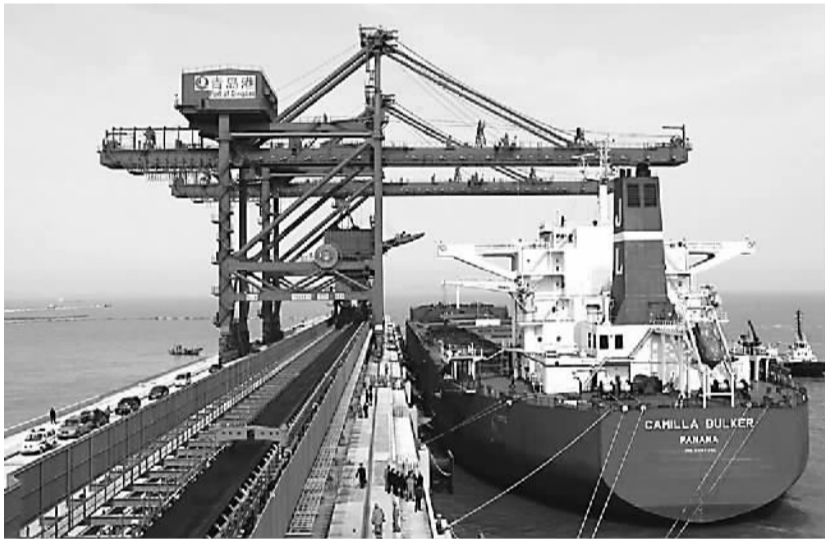
青岛董家口30万吨级矿石码头
