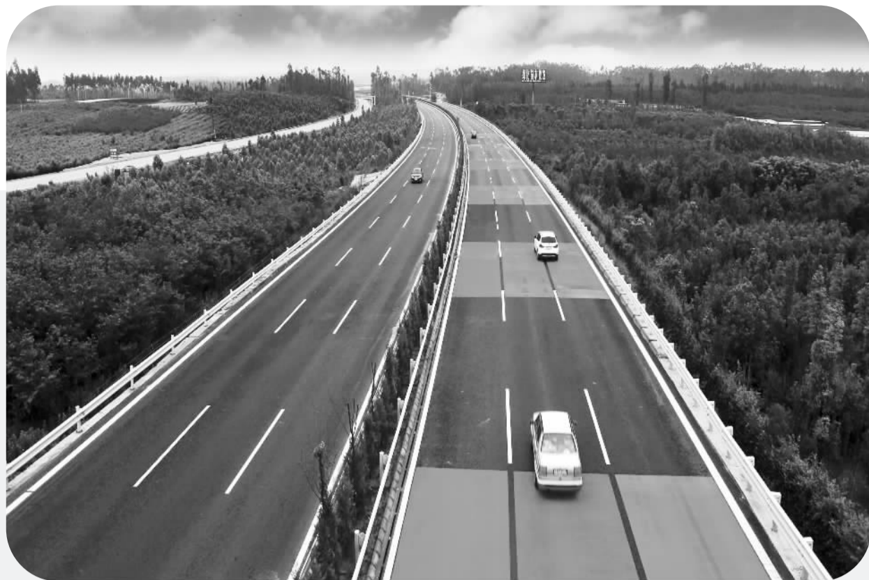
云南公投投资建设的云南石西高速公路。
