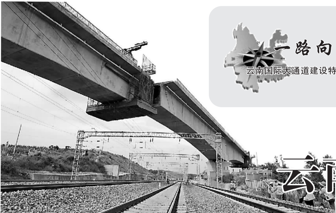
2014年9月10日，沪昆客专云南段沾益特大桥铁路桥梁成功转体合龙。
