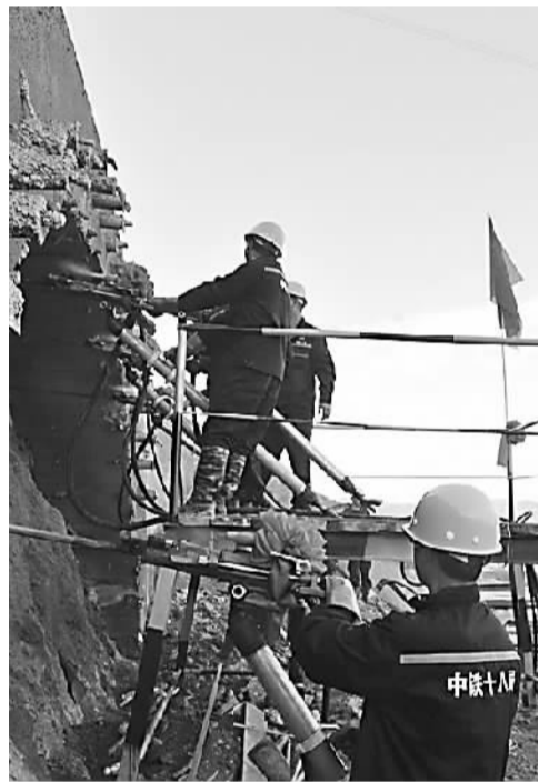
2014年12月29日，大瑞铁路重点控制性工程、亚洲最长的山岭铁路隧道高黎贡山隧道开工。
