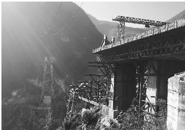
大瑞铁路保瑞段铁路澜沧江特大桥。
