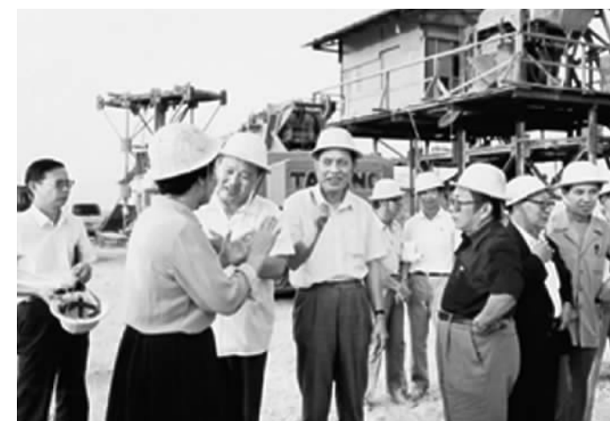
图为一九八六年十月十五日，李灏（左四）在深圳黄港口岸建筑工地研究基建项目建设情况。
