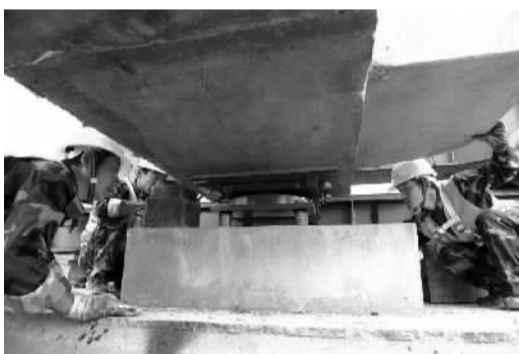
泛亚中线昆明至玉溪扩能改造施工中。
