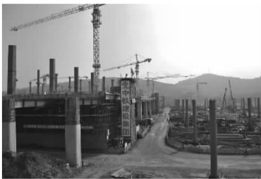
施工中的昆明南站。
