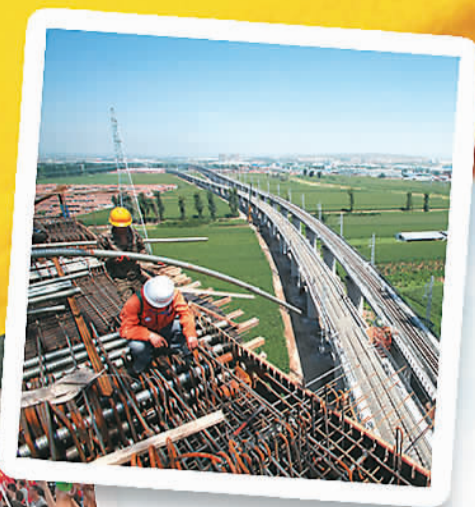
8月4日，工人在张呼（张家口—呼和浩特）铁路工程现场施工。武殿森 刘亭立摄
