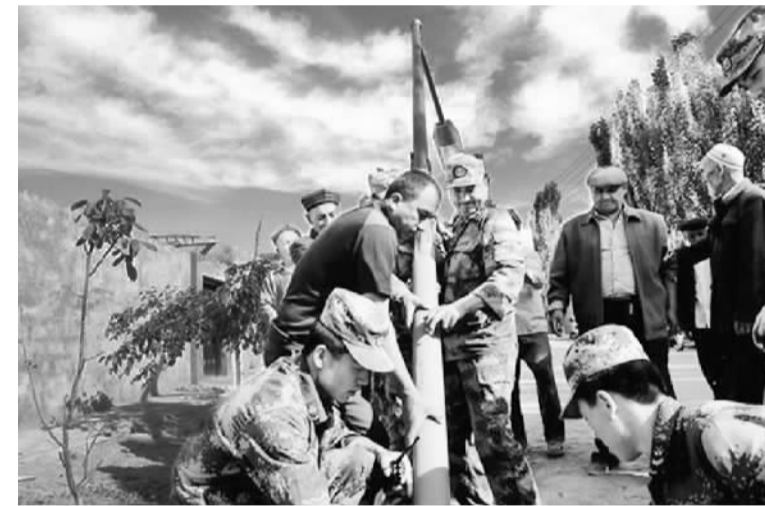
部队为疏勒县的道路安装路灯。
