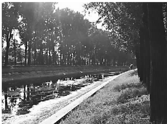
京密引水渠白浮泉段
