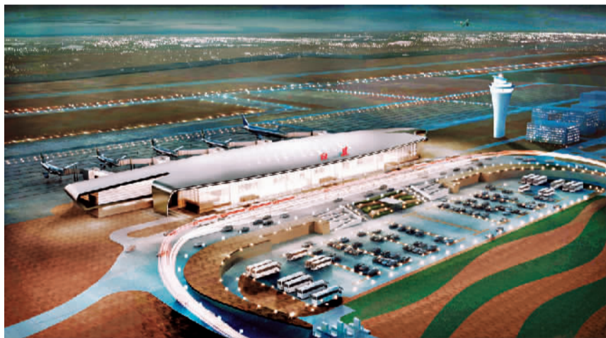
正在建设的日照民用机场
