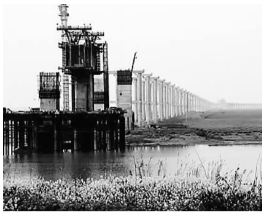
湖北罗霍州大桥建设现场 张荷摄
