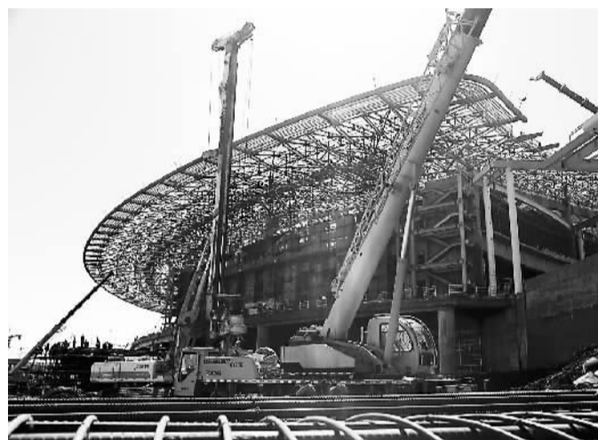
乌鲁木齐新客站建设进入攻坚阶段，预计2015年底建成投入使用，建成后将成为新疆最大的火车客运站。新客站将进一步凸显乌鲁木齐在新疆“一带一路”核心区建设中的区位优势。 王生政摄（人民图片）
