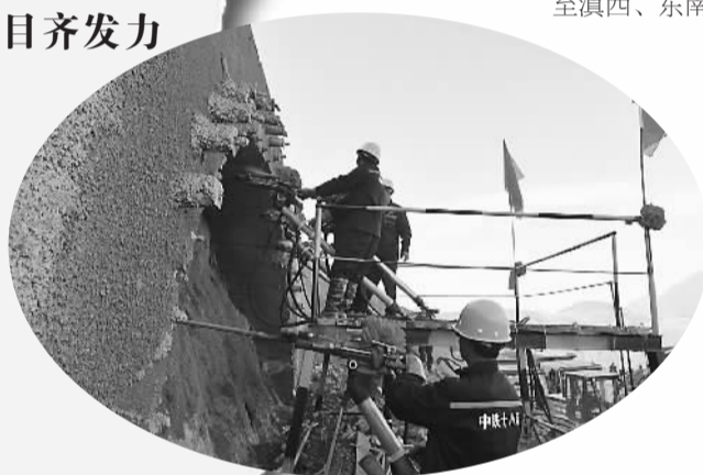
大瑞铁路施工现场
