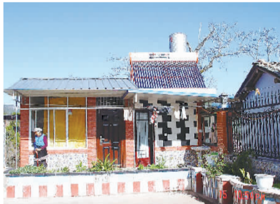
强帮扶村建设项目(洱源胜利水井太阳能建设)
