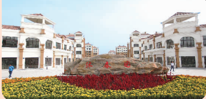
棚户区改造项目——沐春园
