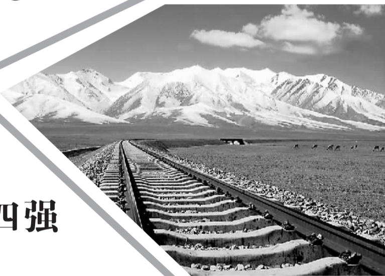
中国铁建修建了青藏高原的第一条铁路
