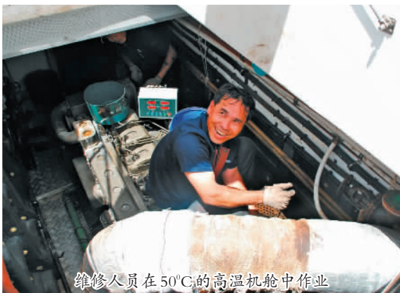
维修人员在50°C的高温机舱中作业
